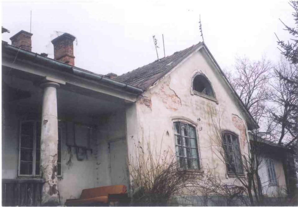
7. Ryzalit i portyk w elewacji tylnej, ogrodowej
