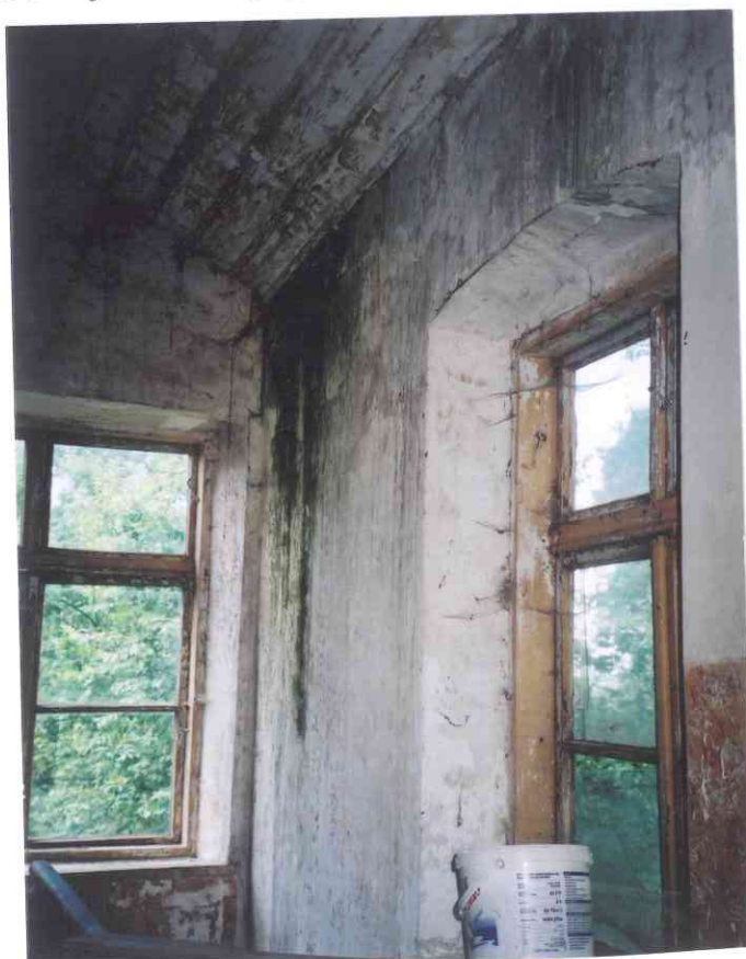
38. Fragment sufitu i ściany na Piętrze w klatce schodowej
