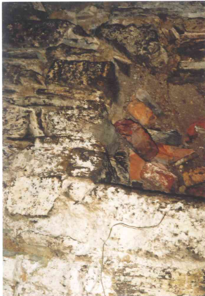
60. Fragment ściany piwnicy uzupełnionej cegłą
