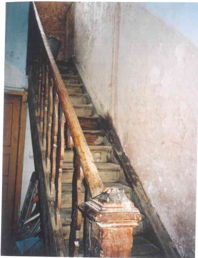
39. Schody w skrzydle piętrowym
