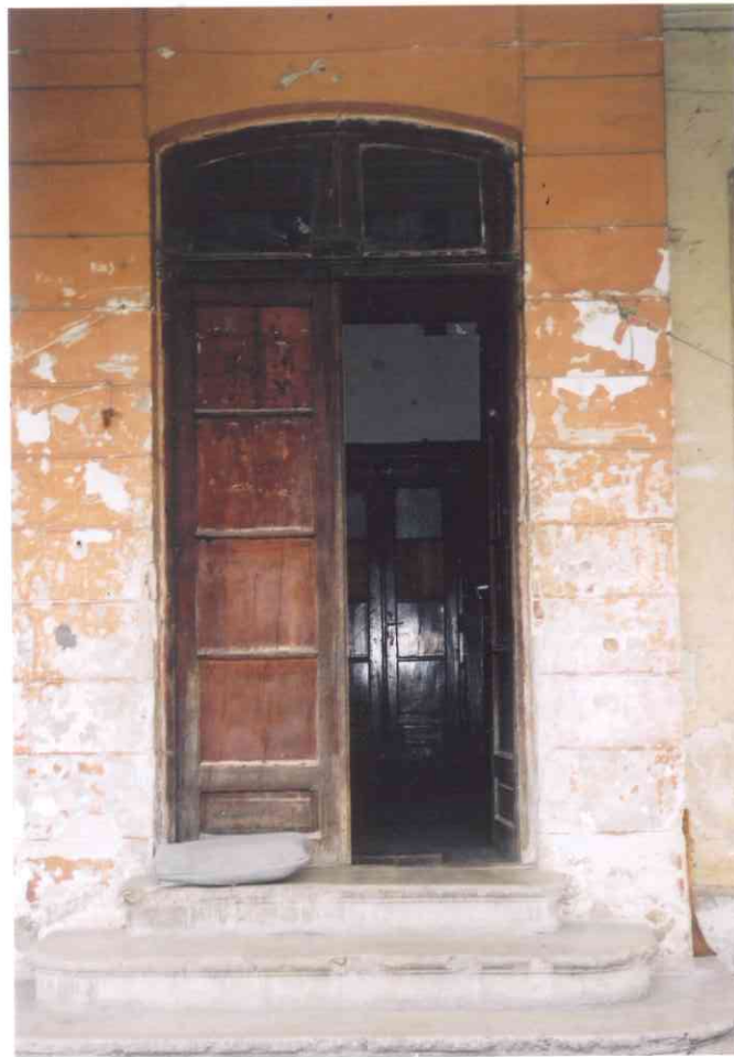
54. Drzwi i schody wejściowe
