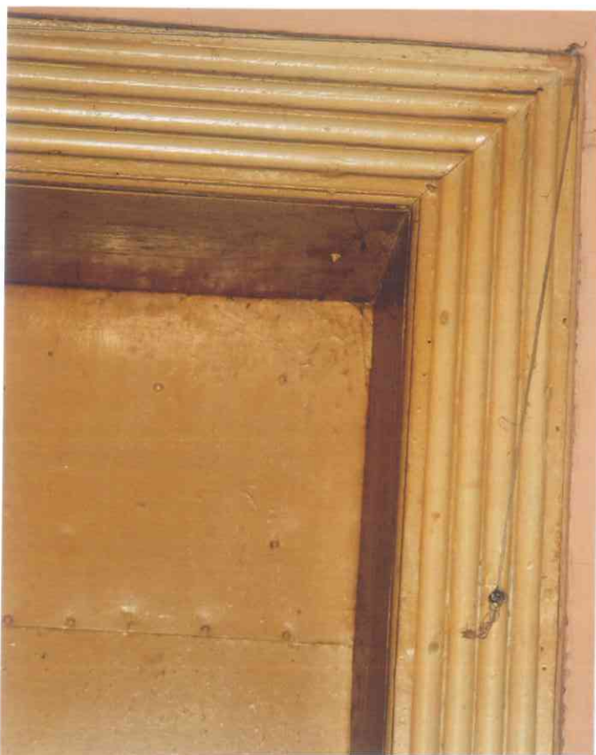
49. Profilowane obramienie wokół otworu drzwiowego na piętrze
