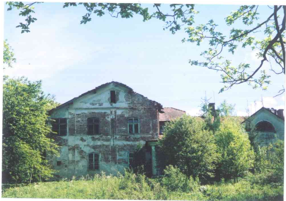
18. Fragment skrzydła piętrowego elewacji tylnej
