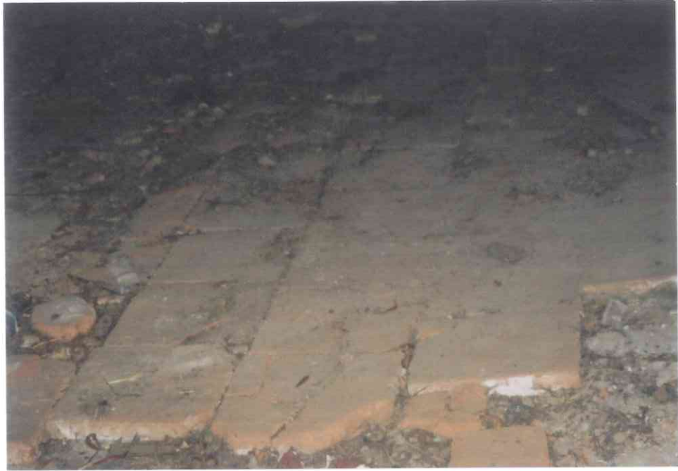
35. Gliniane płytki na strychu
