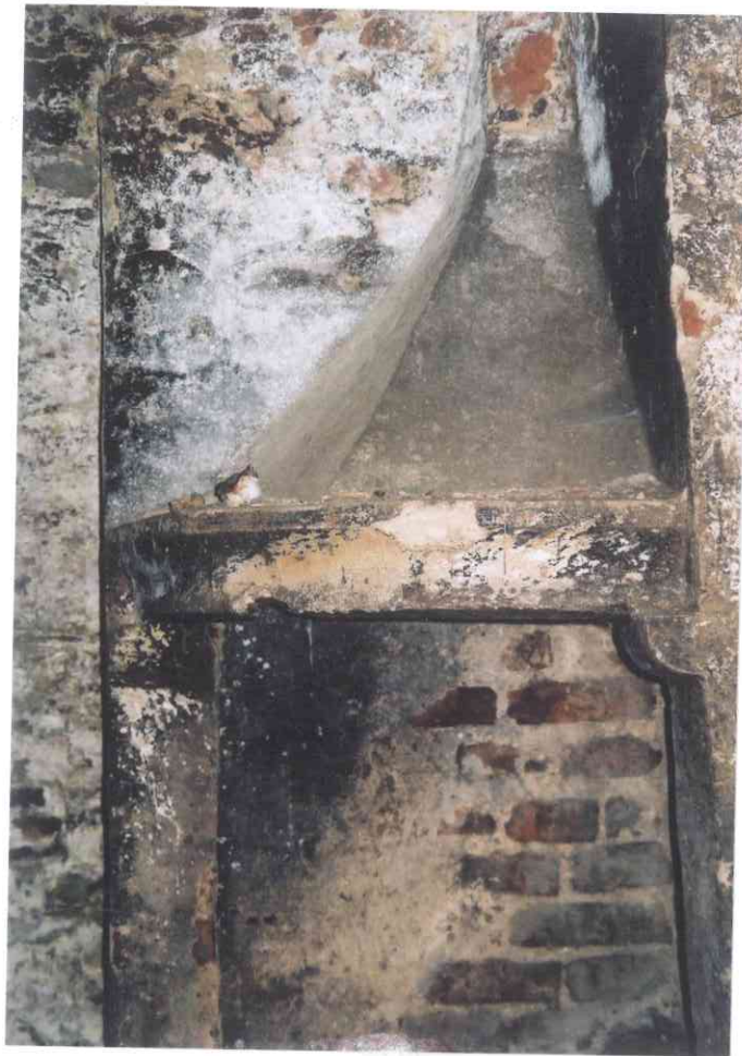
57. Istniejący piec w jednej z komór piwnicznych
